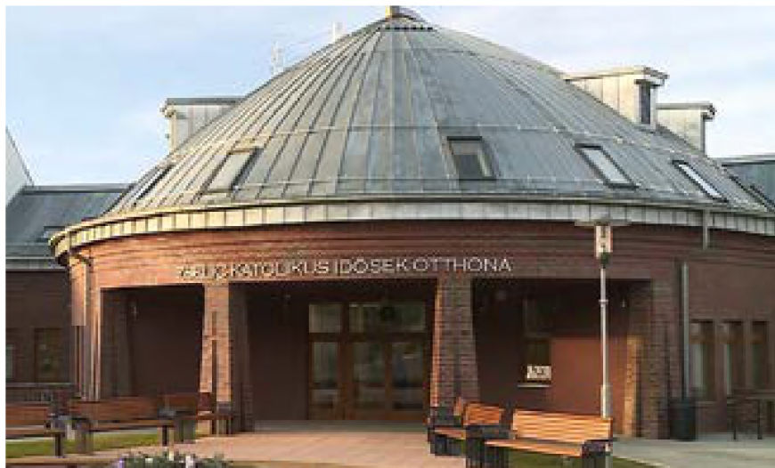
Grand Prix metallkatuste kategoorias: vanadekodu Zselicis Ungaris. Ehitaja oli Stang Badogos Kft, katusematerjal Rheinzink topeltvalts titaantsink.
