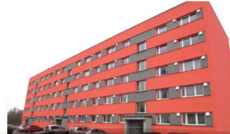
Korterelamu fassaadi ja katuse soojustamine
