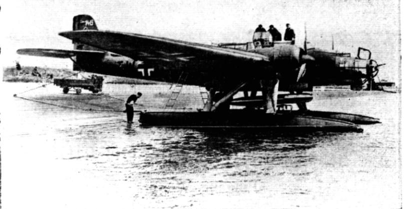
Ein Torpedoflugzeug kurz vor dem Start. Links: Im Transportkarren wird der Torpedo zum Flugzeug gebracht
