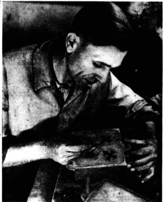
Das Herausnehmen des Eisernen Kreuzes nach dem Guss aus der Form
