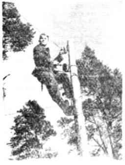
Zus. der Tanne wird ein Telemannist die Leitungsdraht werden an den Isolatoren befestigt. PK-RAD-Arnold: Kriegerbcher Auln (Wb)
