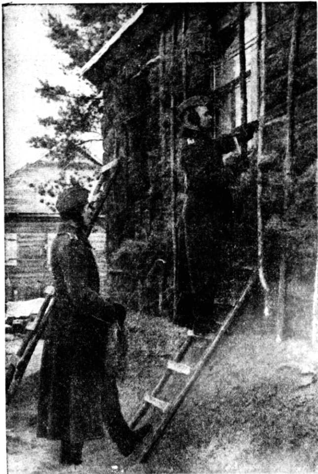
Die Hauswände werden mit Flachsbündeln verkleidet, damit die Winterkälte besser abgehalten wird
