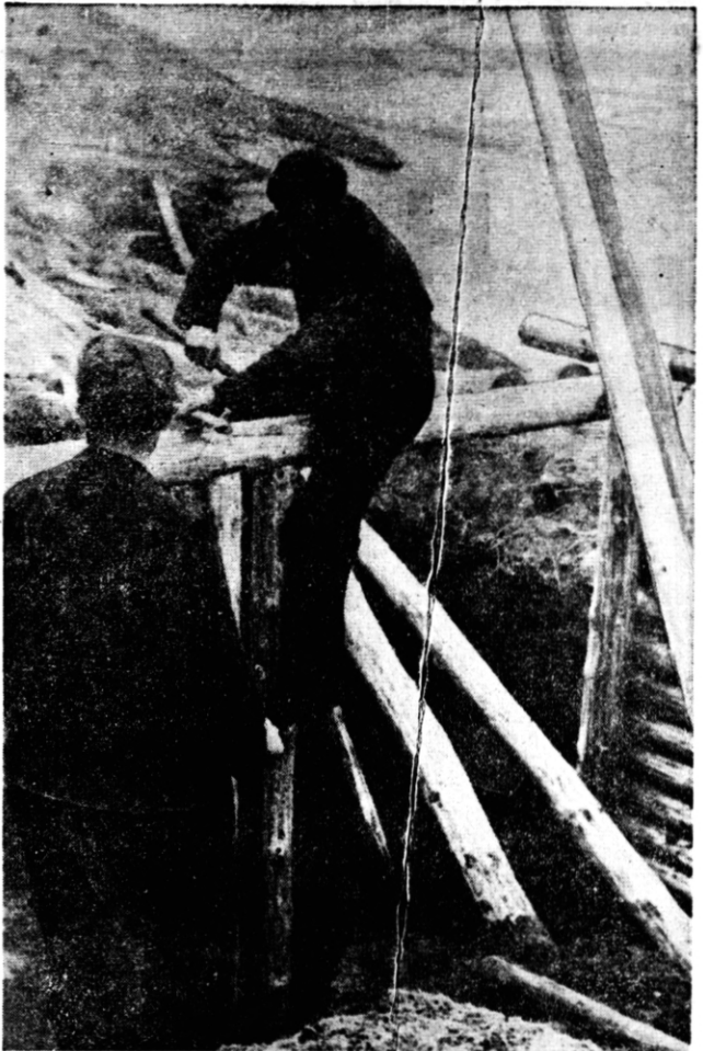
Bunker werden gebaut
