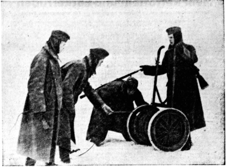
Nur kurze Zeit dauert es, bis das beschädigte Kabel trotz Eis und Schnee mit Hilfe des Verlegewagens ausgewechselt ist
