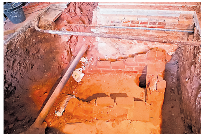
Kiriku põranda alt pole Eestis selliseid hauakambreid varem välja tulnud. Foto: Hendrik Osula
