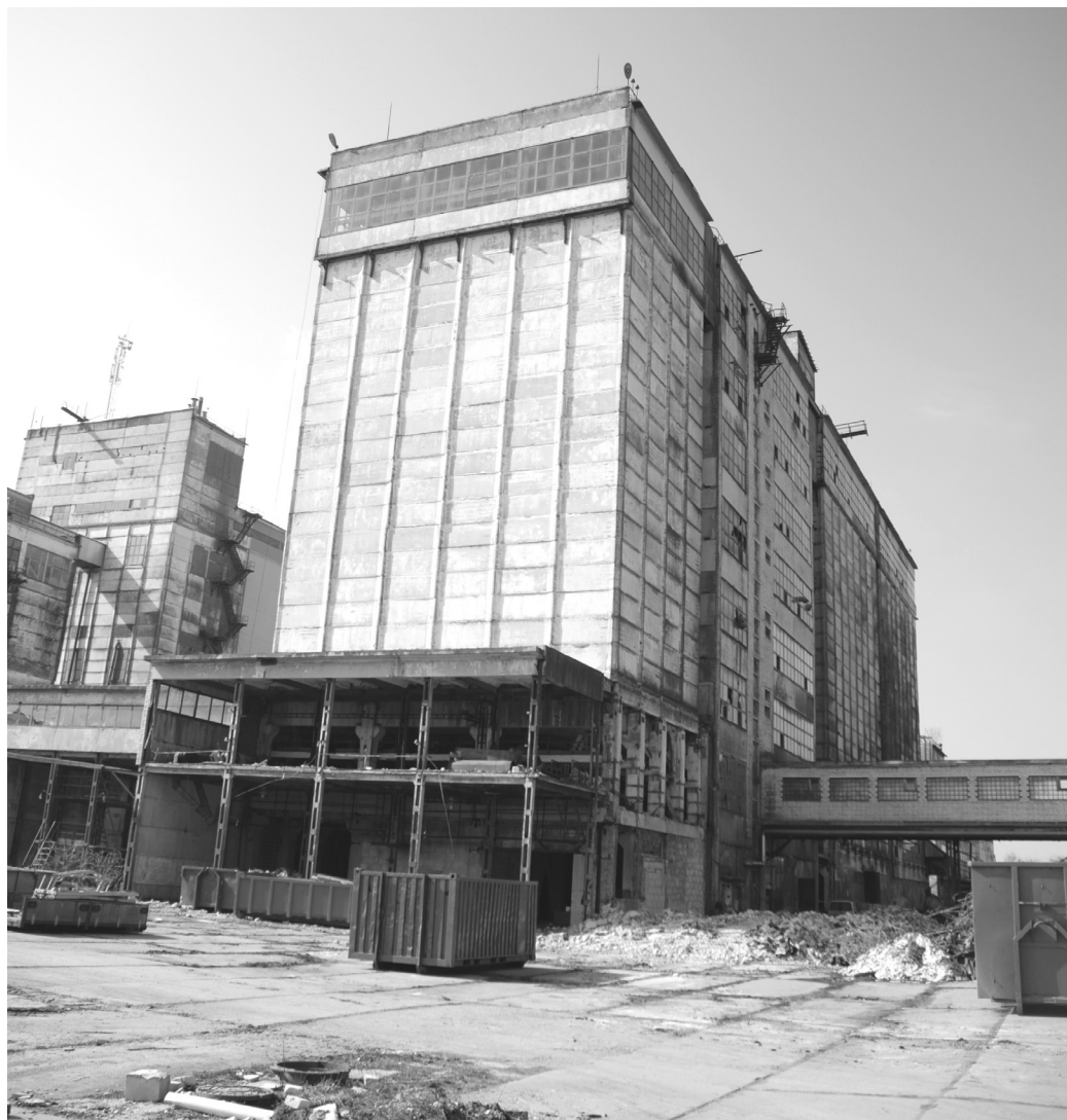
Vasakul asuv elevaatorihoonne jääb puisti. Alles jäävad ka kaks parempoolset elevaatorit, mis kaetakse plekkvoodriga. Lammutatakse esiplaanil olev hooneosa. Allar Viivik
