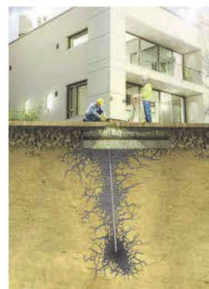
билизации полов складских помещений даже не нужно выносить стеллажи с разложенным на них товаром. Для достижения лучшего результата нагрузка на поднимаемый грунт даже необходима. То есть весь вес, который обычно на этом месте находится, даже должен оста-
