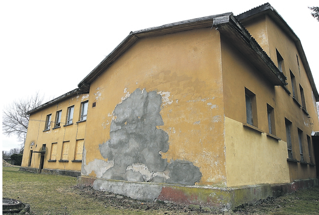
Euroraha taotletakse ka Rapla õpilaskodu rekonstrueerimisele.
