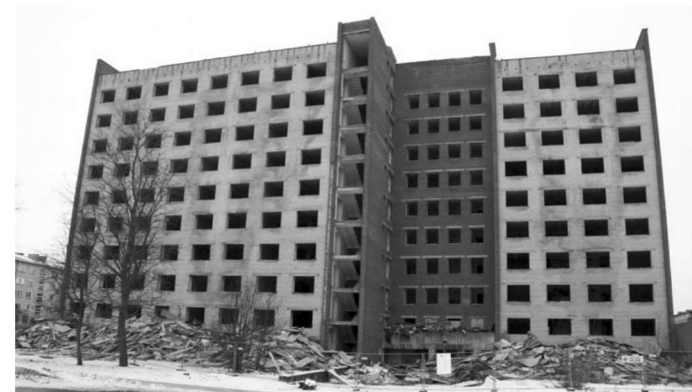
Alates jaanuarist demonteeritakse Kalevi 33 asuvas hoones põrandaid, vaheseinu ja aknaraame. PEETER LILLEVÄLI
