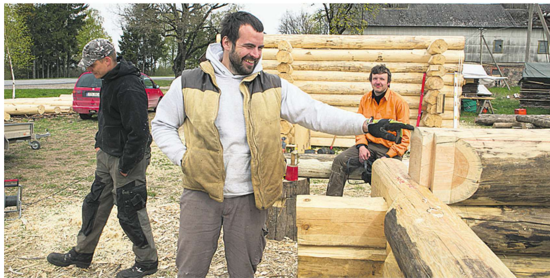
Üks praktika juhendajaid Tarmo Tammekivi näitab, kuhu paigutatakse sügisel murispuud, mille ülesanne on hoida ehitise kõik neli nurka enam-vähem samal kõrgusel.
