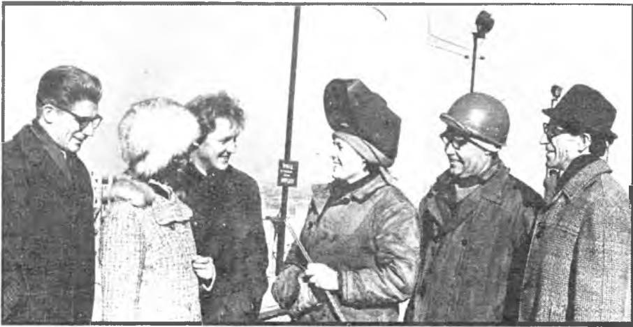
H. Rajamets, L. Promet, A. Valton ning R. Parve vestlemas Kanivi hüdroelektrijaama ehitajate N. Gavruha ja V. Antonoviga.
