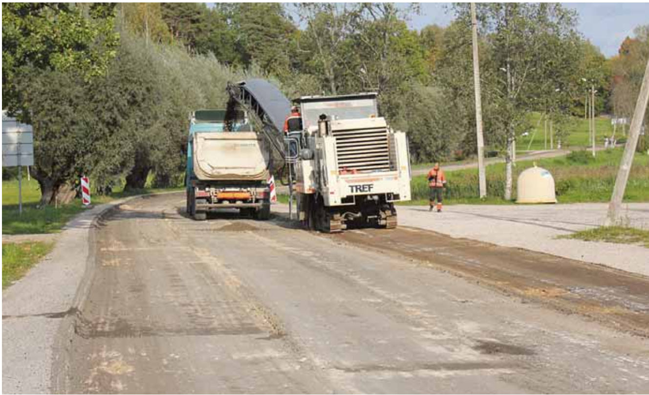
Rõuge teetöid alustati asfaldi ülesfreesimisega.
